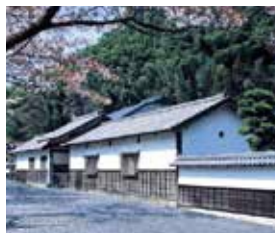
だい かん しょ ぶと いわ み ざん ぶん しりょう かん *2 代官所跡 (石見銀山資料館)
