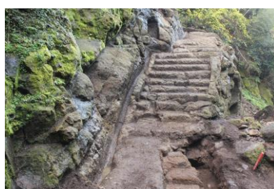
岩盤を加工した階段
