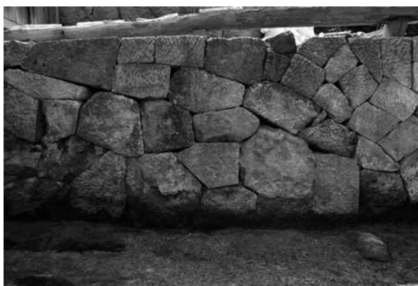
同 本殿西側石垣(北西より)
