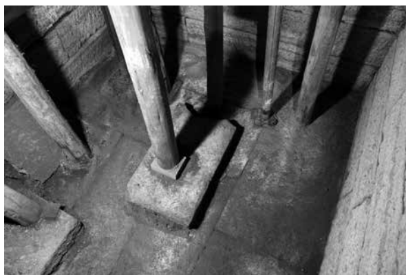
同 SX 03 内部完掘状況 (北東より)
