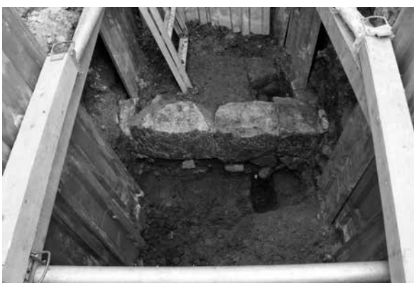
同 裏門立会トレンチ完掘状況 (南より)
