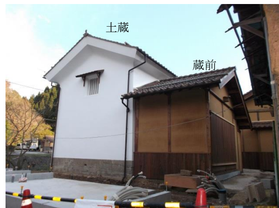
竣工（土蔵・蔵前）
